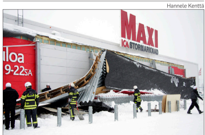
Palomiehet varmistivat, ettei Ica Maxin romahtaneen katoksen alle jäänyt ketään.
